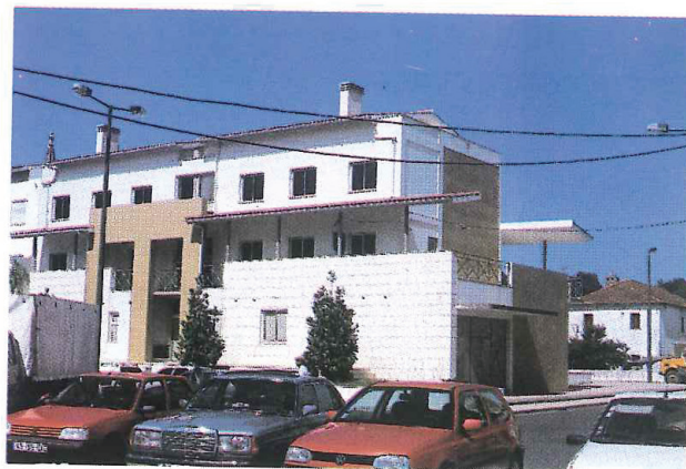
Figs. 22-24 - Fachadas separadas do corpo do edifício para dar visibilidade à casa retirando a luz ao interior e a visão às janelas.
