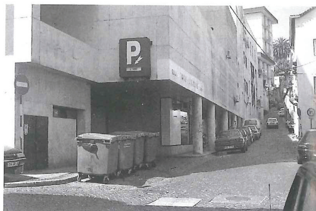
Fig. 51 - O passeio termina num parque subterrâneo entre contentores de lixo.
