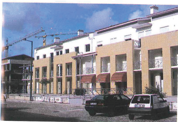
Figs. 22-24 - Fachadas separadas do corpo do edifício para dar visibilidade à casa retirando a luz ao interior e a visão às janelas.
